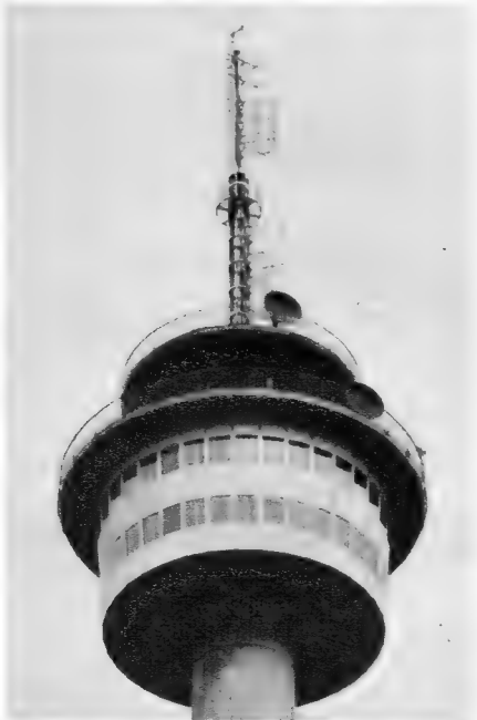
Radarzentrale Bremerhaven im neuen Fernmeldeturm
